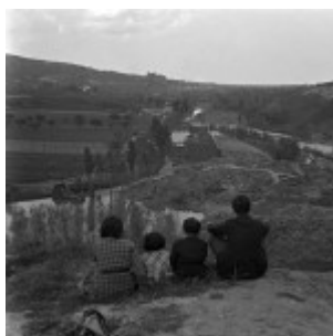
Fig. 8. Veduta della frana che chiuse il fiume Montone sopra Castrocaro (aprile 1938), foto n. 779;
